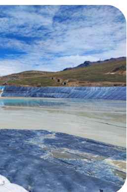
ESTABILIZACIÓN DE TALUDES
