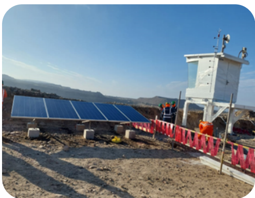
SISTEMA OFF GRID PARA CASETA
