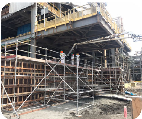
CONSTRUCCIÓN DE MURO DE CONTENCIÓN Y RAMPA
