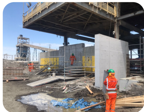
CONSTRUCCIÓN DE MURO DE CONTENCIÓN Y RAMPA
