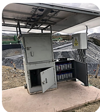
SISTEMA OFF GRID PARA CASETA
