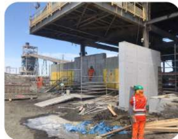
CONSTRUCCIÓN DE MURO DE CONTENCIÓN Y RAMPA
