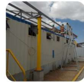
CONSTRUCCIÓN DE DRENAJE
