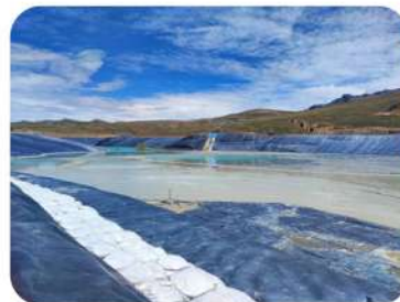
ESTABILIZACIÓN DE TALUDES
