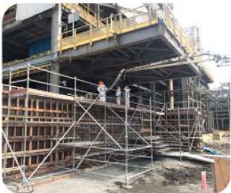
CONSTRUCCIÓN DE MURO DE CONTENCIÓN Y RAMPA
