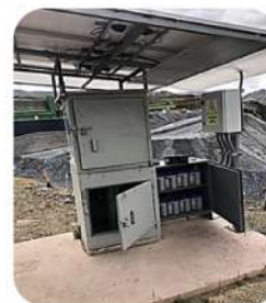
SISTEMA OFF GRID PARA CASETA
