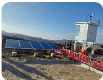
SISTEMA OFF GRID PARA CASETA
